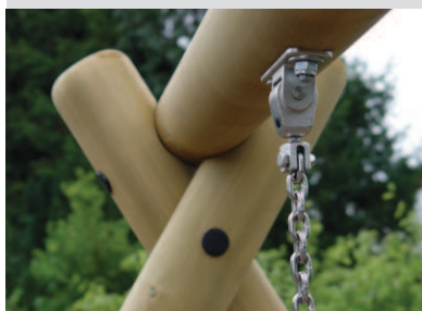
detail spoje sloupů s překládem
