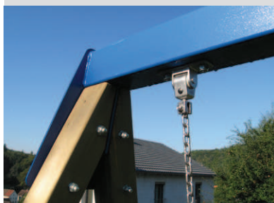
detail spoje sloupů s překládem
